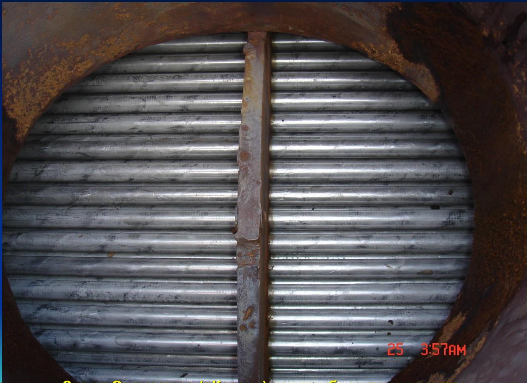
Завод Оргсинтеза (г.Казань), межтрубное пространство после очистки от кокса пирогаза по технологии RVR-PM
