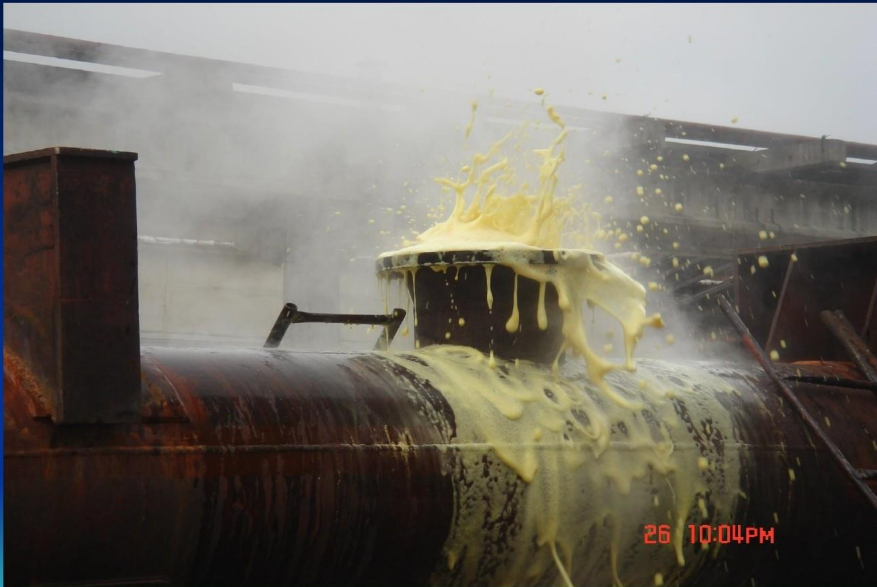
Завод Оргсинтеза (г.Казань), очистка межтрубного пространства по технологии RVR-PM от кокса пирогаза fl.ili.ru
