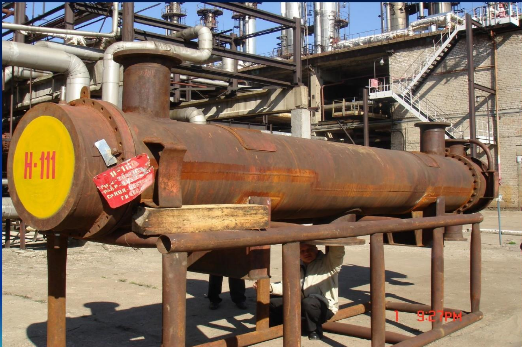
Завод Оргсинтеза (г.Казань), очистка межтрубного пространства по технологии RVR-PM от кокса пирогаза
