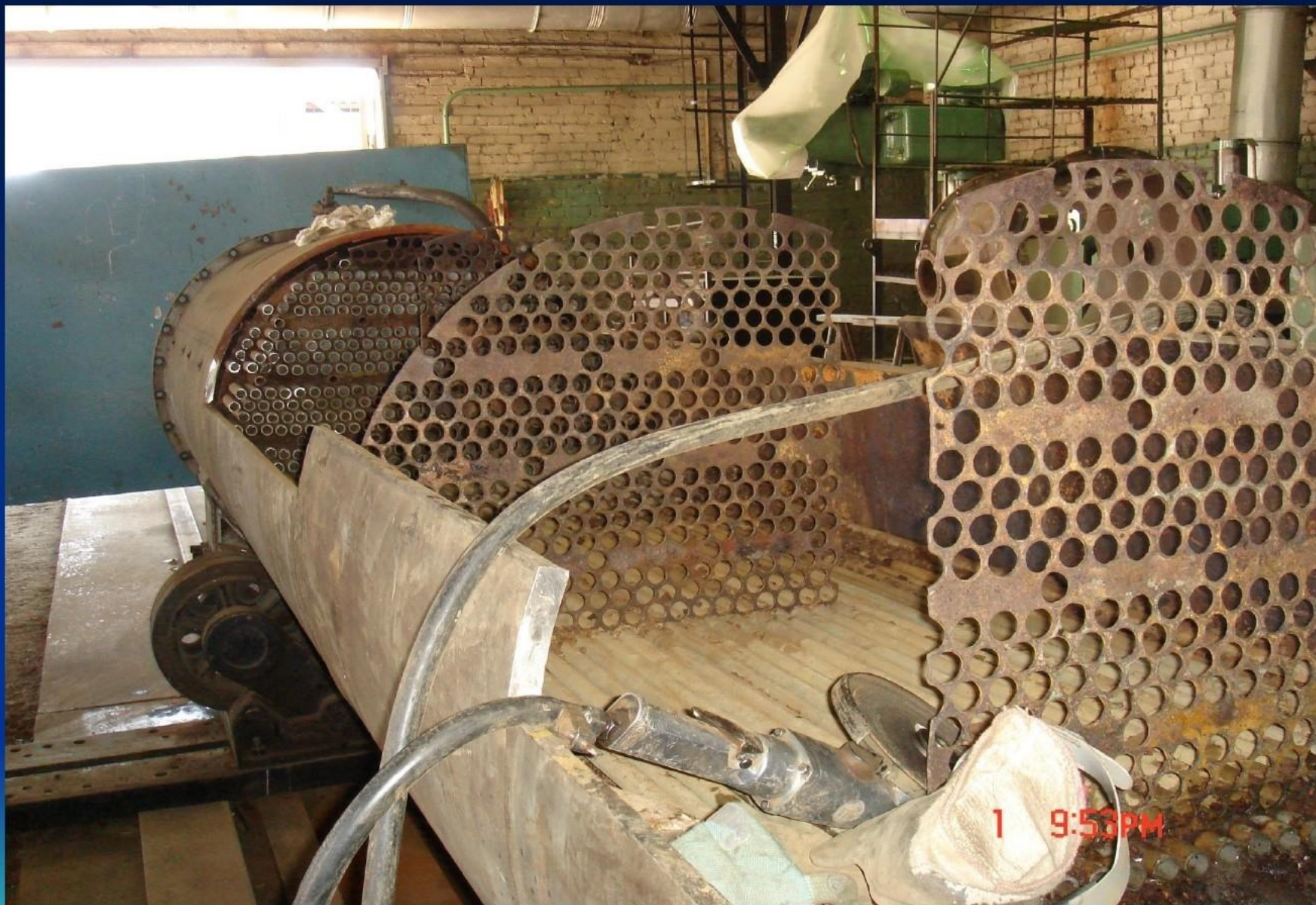
Завод Оргсинтеза (г.Казань), очистка межтрубного пространства fl.ili.ru По традиционной технологии от кокса пирогаза
